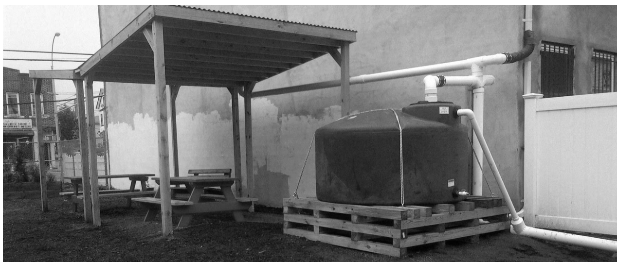
Ryc.5. Konstrukcja umożliwiająca efektywne zbieranie deszczówki
