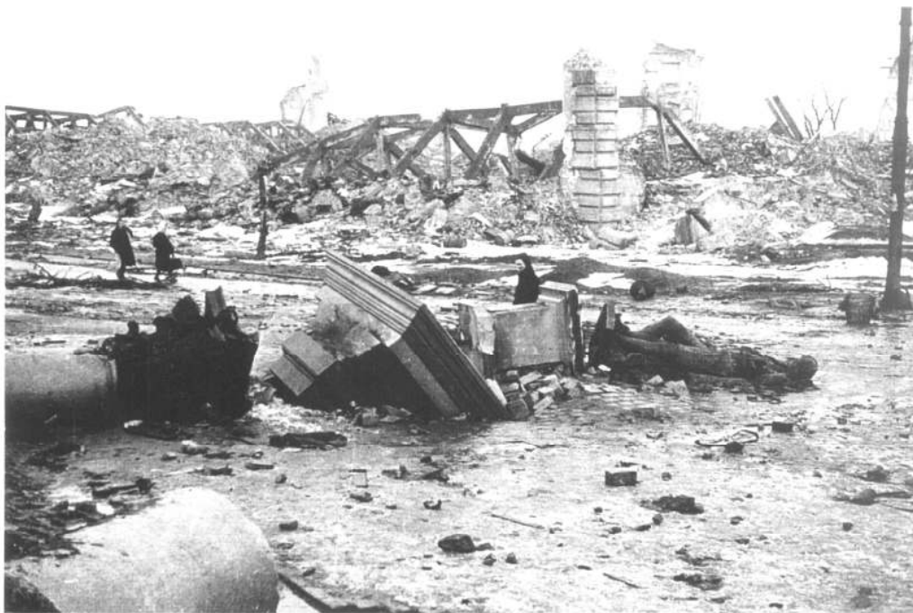
Ryc. 53. Symbol zrujnowanej Warszawy – roztrzaskana kolumna Zygmunta
