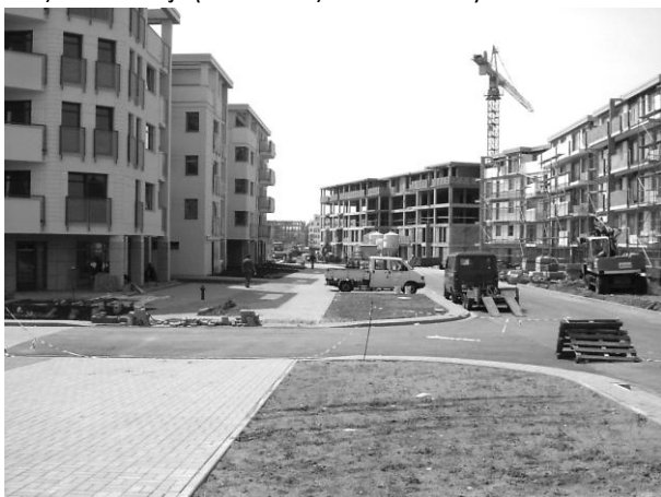
Rys. 101. Nowopowstająca zabudowa na obszarze Wilanova Zachodniego, wzdłuż ulicy Klimczaka. (M. Kaczyńska, 2006)
