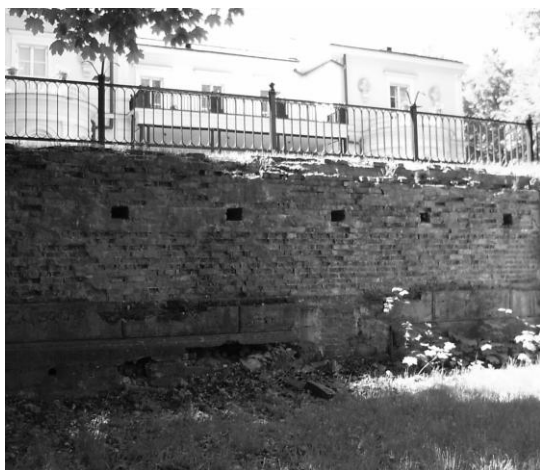
Rys. 20. Mur oporowy przy pałacu w Ursynowie. (M. Kaczyńska, 2005)
