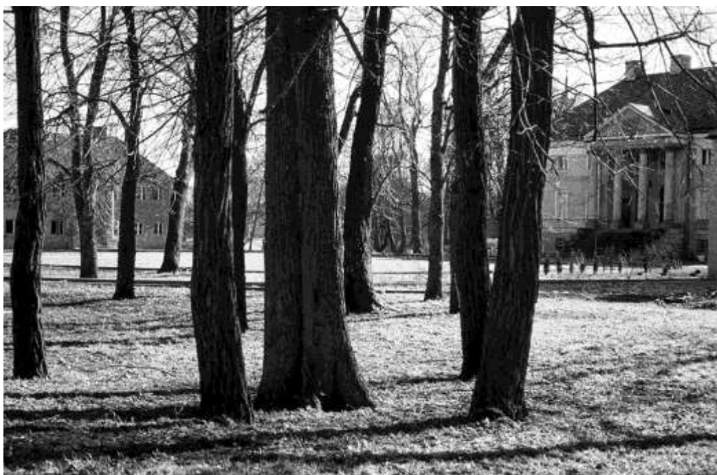
Ryc.140a. Założenie palladiańskie w Siernikach. Elewacja frontowa (fot. autor, 2002)
