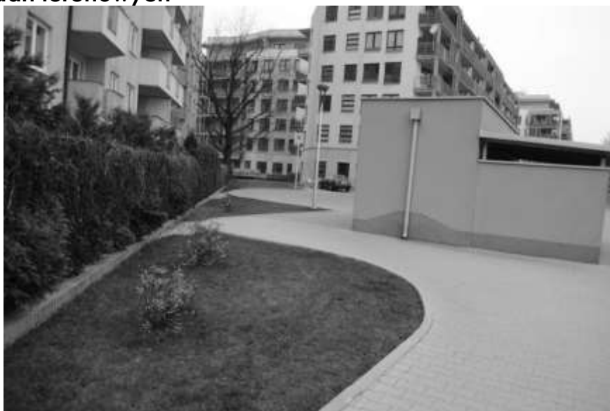
Ryc. 2 Widok wiaty śmietnikowej na osiedlu. (Autor fot. Magdalena Myszka, data 22.10.2012)
