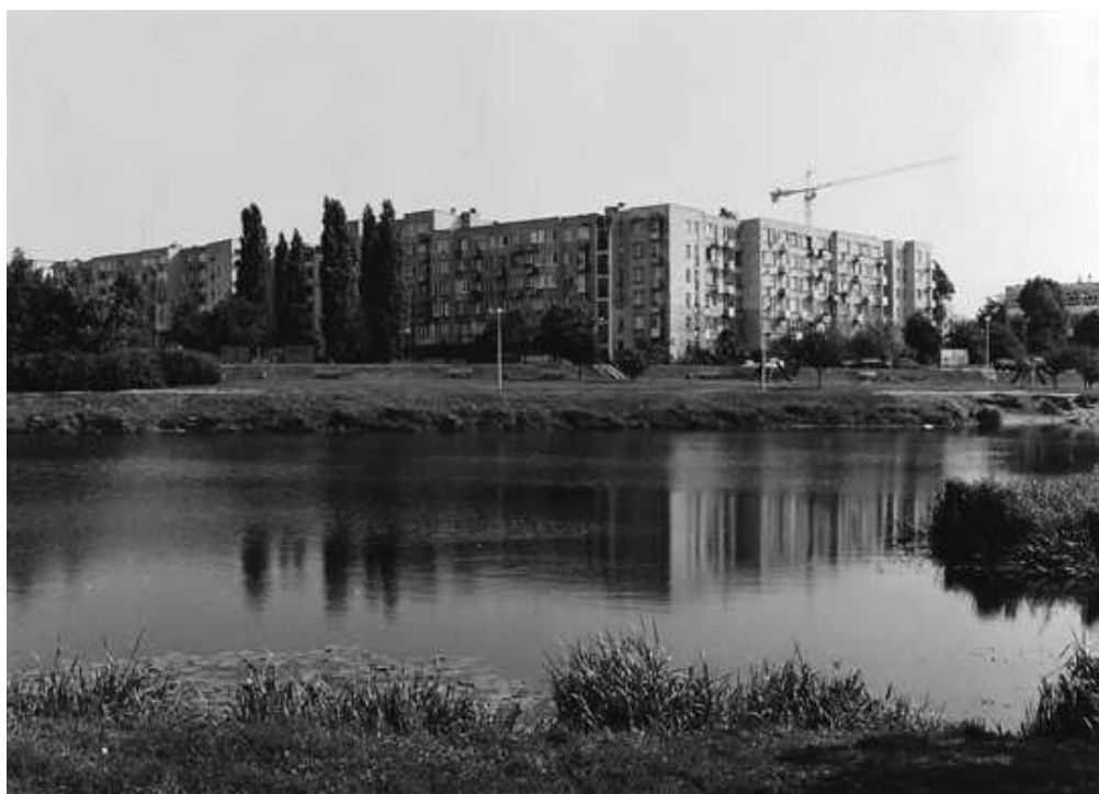
Rys. 31. Osiedle mieszkaniowe na Przyczółku Gocławskim.
